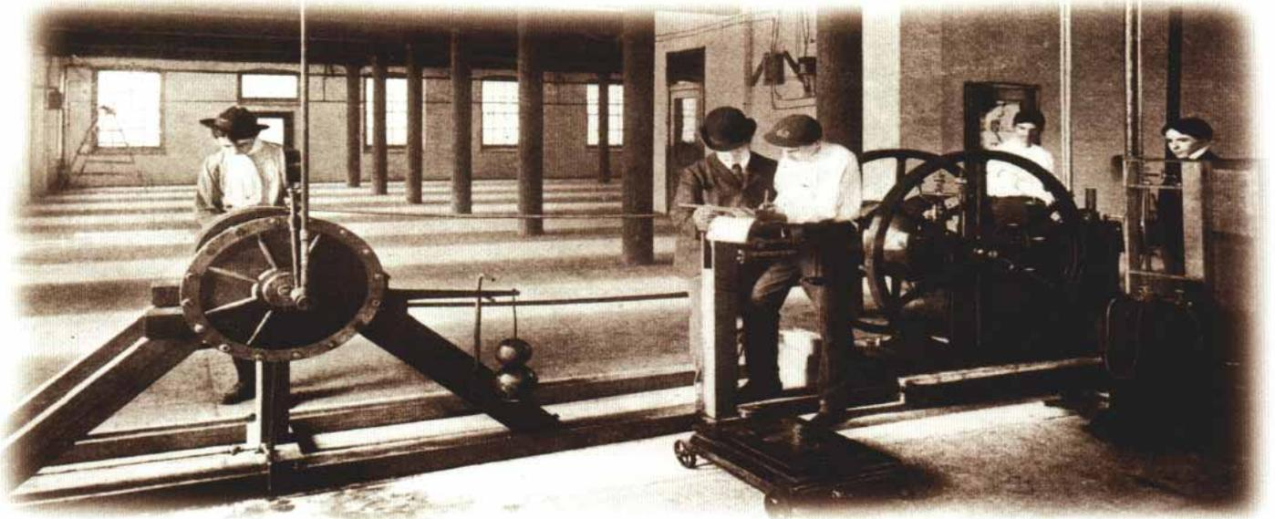
TESTING A GAS ENGINE FOR HORSEPOWER IN 1904.
