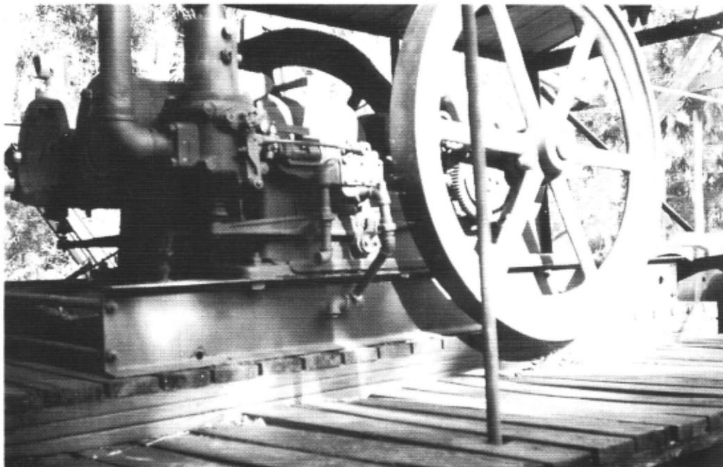
FIG. 4 – 50H.P. TWIN CYLINDER MULTI-FUEL ENGINE
